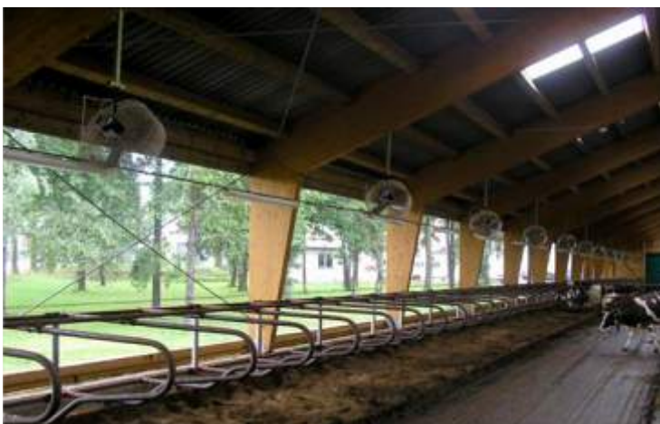
Návrh rozmístění ventilátorů v klasické 6-ti řadě stáji
